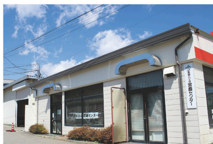
野辺山営農センター 生産資材 外観
